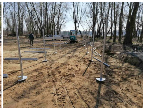
14. ábra Vízibázis és rendezvényközpont, Szabolcsveresmart (gyámolított lemezalapot) (Tervezés, Gyártás: Terra-Vallum Kft. Kivitelezés: Szabó-Tetőmester Kft.)
