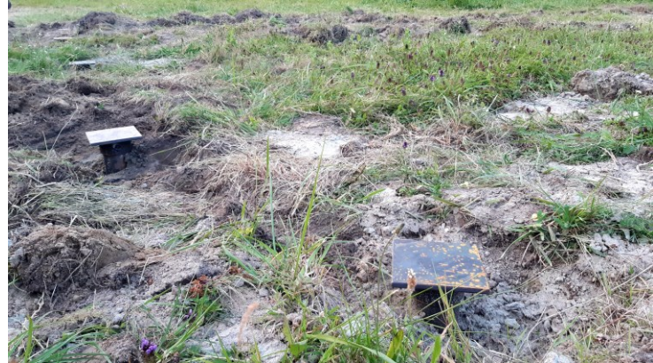
15. ábra Lakóház, Balatonmárfafürdő (gyámoltott sávalap, cölöp: 220kN, 8m) (Tervezés, Gyártás, Kivitelezés: Terra-Vallum Kft.)
