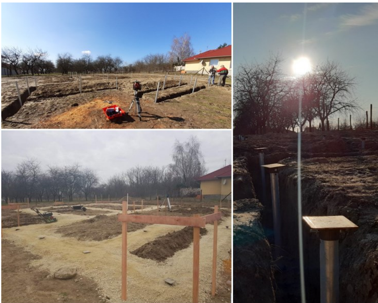
17. ábra Lakóház, Dunaföldvár (gyámolított sávalap) (Tervezés, Gyártás: Terra-Vallum Kft. Kivitelezés: talajcsavar.hu)
