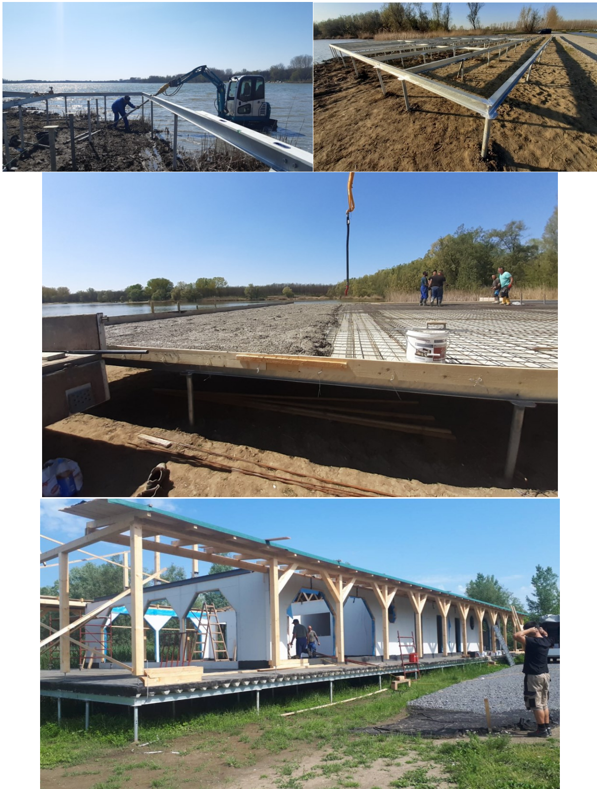
12. ábra Látogatóközpont, Szabolcsveresmart (cölöp: 80kN, 7,5m) (Tervezés, Gyártás: Terra-Vallum Kft. Kivitelezés: Szabó-Tetőmester Kft.)
