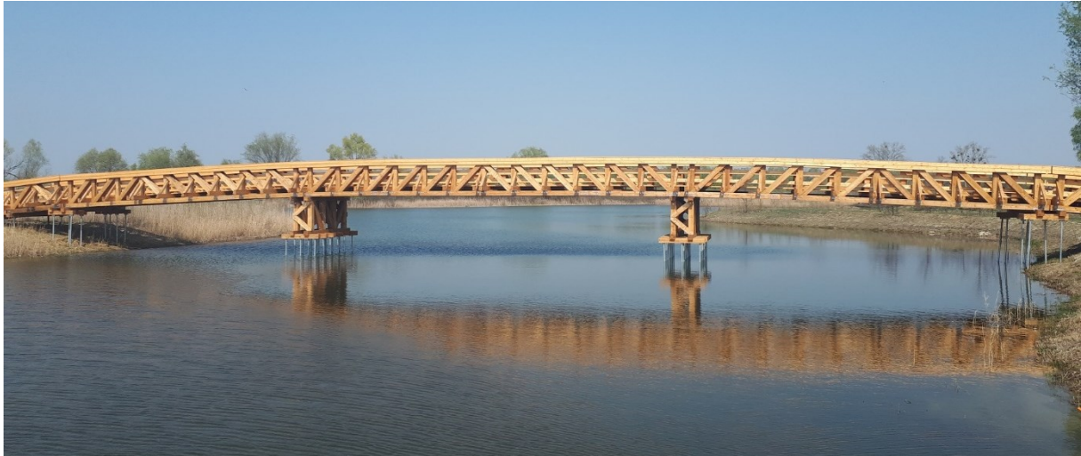
13. ábra Gyalogos fahidak, Kisvárdá (cölöpcsoport: 360kN, 6m) (Cölöptervezés, Gyártás: Terra-Vallum Kft. Kivitelezés: Szabó-Tetőmester Kft.)
